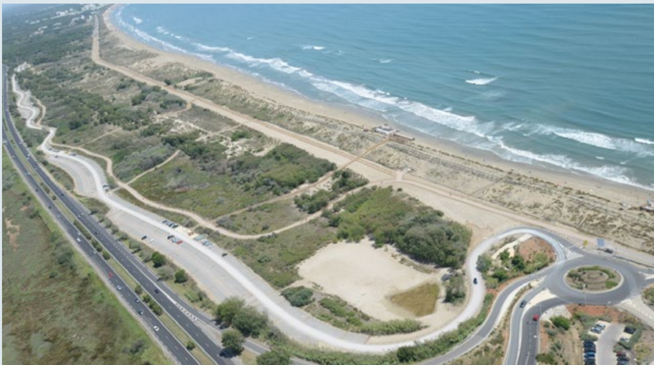
Vue aérienne du site après travaux mais avant cicatrisation végétale. L'emprise de l'ex-RD est encore très visible Photo © Communauté d'agglomération du Pays de l'Or
