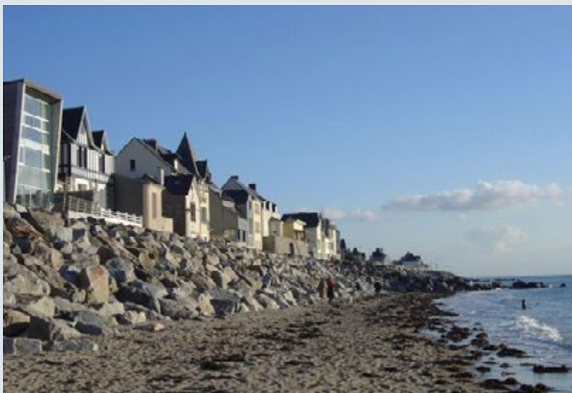
Front de mer de Coutainville avec enrochements longitudinaux, et demain ? Photo © OT Coutainville
