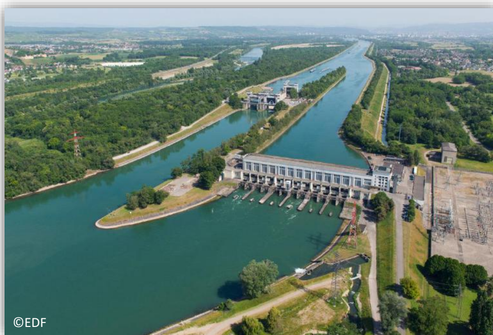
Figure 15 : Centrale hydroélectrique de Kembs
